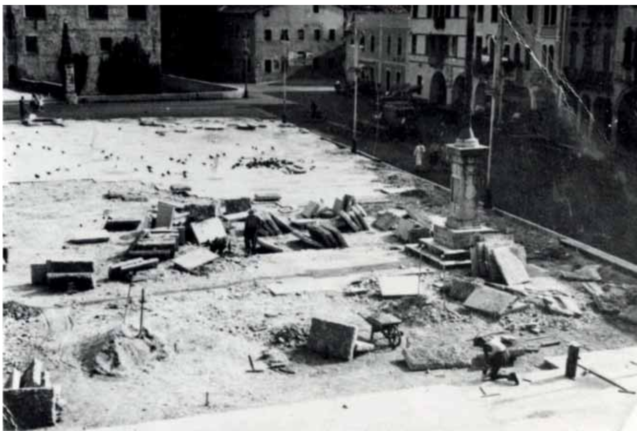
I lavori di rifacimento della Piazza
